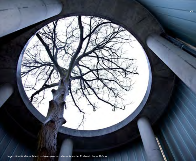
Lagerstätte für die mobilen Hochwasserschutzzelemente an der Rodenkirchener Brücke
